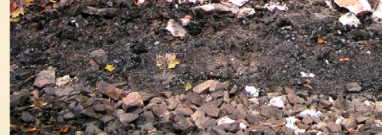
Vápencové bloky boční zdi při vjezdu do tunelu u kterých došlo, při požáru uskladněných prazců, k částečnému poškození
