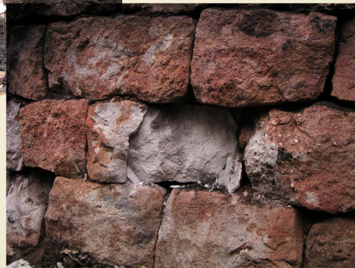
Vápencové bloky boční zdi při vjezdu do tunelu u kterých došlo, při požáru uskladněných prazců, k částečnému poškození
