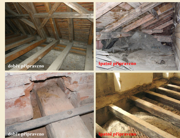
Příprava krovové a stropní konstrukce před průzkumem
