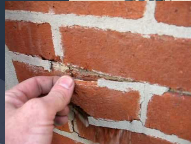
Použití cementu ve starém zdivu
