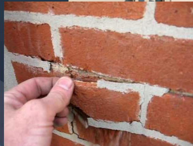
Použití cementu ve starém zdivu
